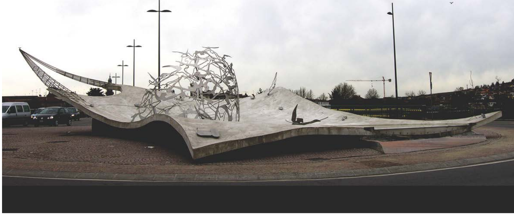
TEATRO D'ACQUA; Fontana in cemento armato e acciaio INOX - 2006
